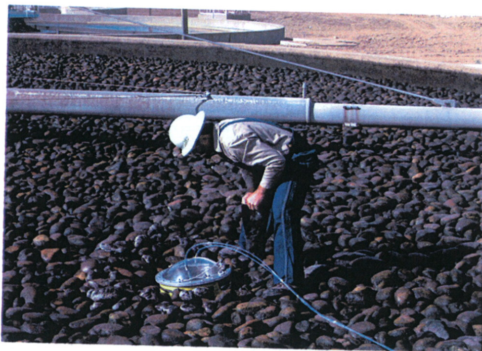
#17&18 - Trickling filter
