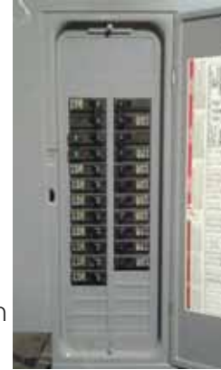
Panel de interruptores de desconexión
